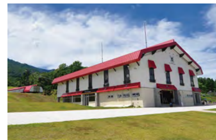
Skycable Bottom sta.
